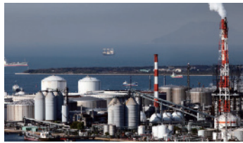
電力プラント
