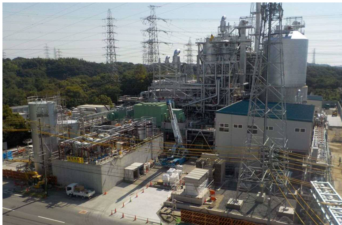
<名南共同エネルギーの発電設備>
