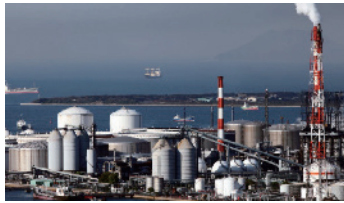
電力プラント
