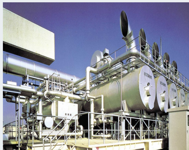
<環境保全設備>
