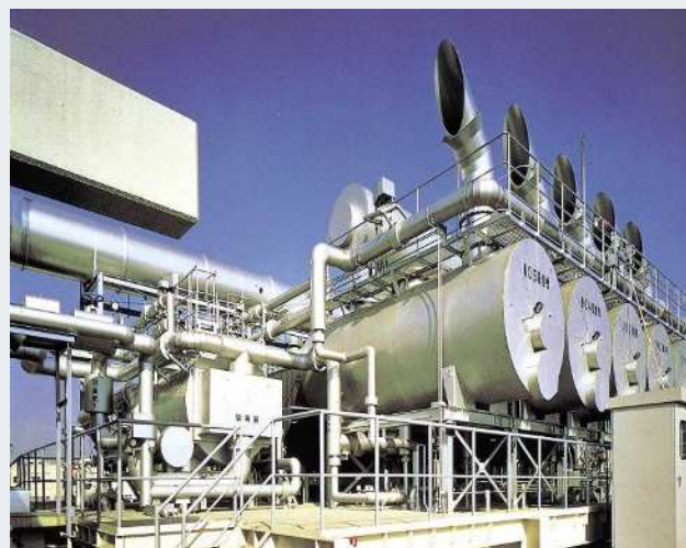
<環境保全設備>
