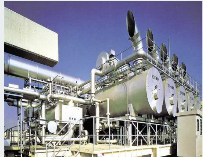
<環境保全設備>
